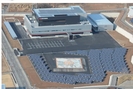
韮崎市穂坂町にある新聞印刷センター。建物は地震災害に強い免震構造で、ヘリポートも備えている
